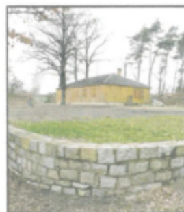
Abb. 04 – Mehrzweckgebäude mit Holzverkleidung, davor geschotterte Platzfläche. Foto: LA Panse 2008
